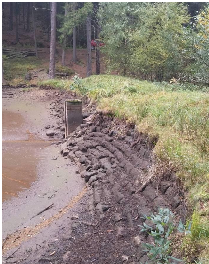
Torzo opevnění návodního svahu hráze horního rybníka.
