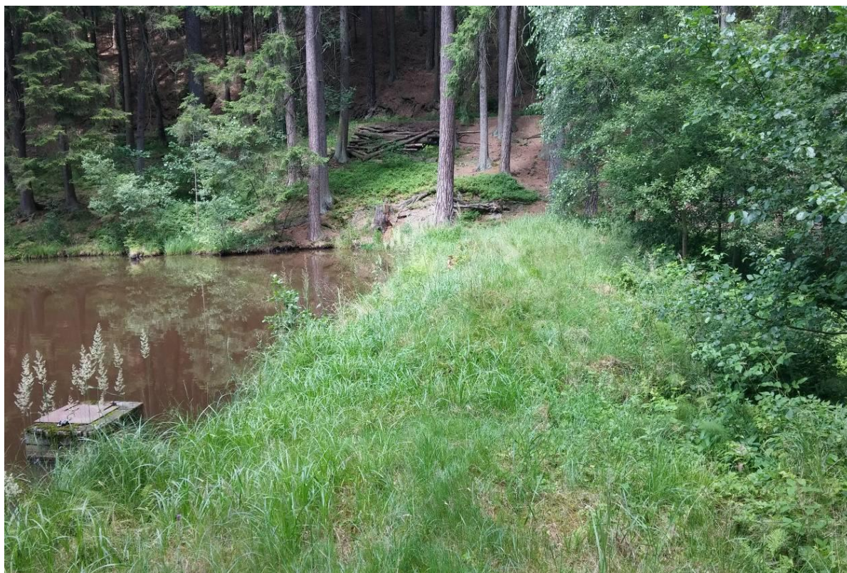
Stávající těleso hráze horního rybníka, které bude dotěsněno a vysvahováno.
